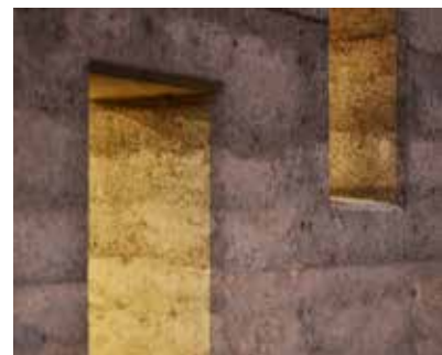
Ouvertures réalisées dans le mur en béton de terre
