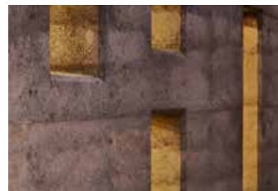
Ouvertures réalisées dans le mur en béton de terre
