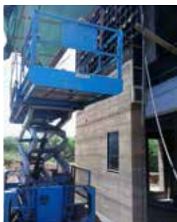
Construction d'un mur en banchage
